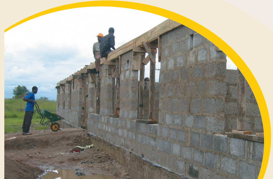
Lusaka, Zambia - Il Centro Polifunzionale "Shalom" in costruzione avanzata. La consegna dei lavori è prevista per il prossimo mese di luglio
