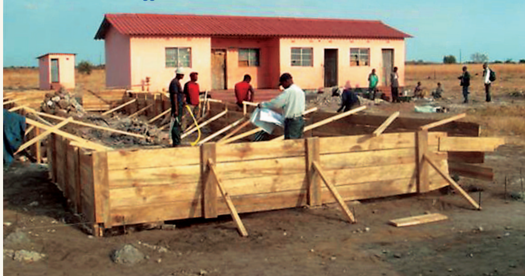
Lusaka (Zambia) maggio 2007 - Sono iniziati i lavori di costruzione del nuovo centro.
